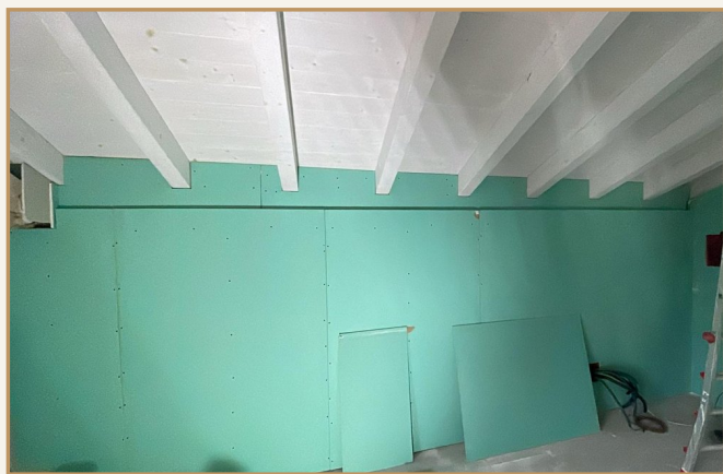
Rivestimento in cartongesso, sottotetto
