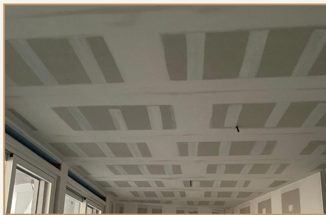
Pareti in cartongesso con stuccatura
