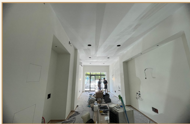
Controsoffitto con faretti e nicchie
