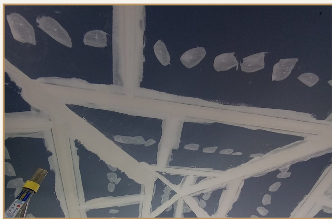
Controsoffitto con stuccatura dei giunti
