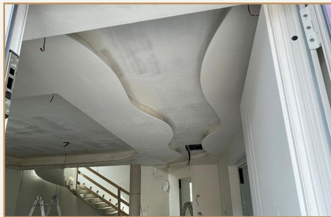
Controsoffitto sagomato, ingresso
