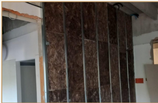
Parete con isolamento termo-acustico
